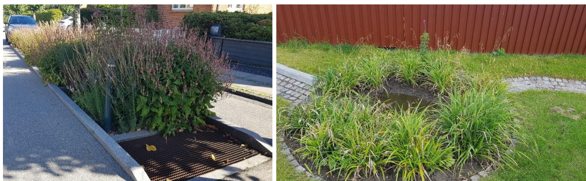
Slika 2: Deževni vrt za zadrževanje in čiščenje padavinskega odtoka iz ulice, parkirišča ali streh: Voda se prečisti prek filtracije skozi substrat, mikrobnega delovanja in rastlinskega privzema. Deževni vrtovi so tudi lep estetski element, ki povečuje bioraznovernost in blaži efekt vročinskega otoka v mestih. (Foto: D. Istenič)
