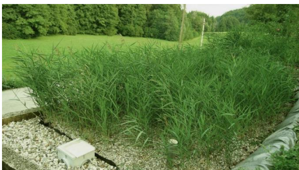
Slika 4: Rastlinske čistilne naprave so sonaravna, učinkovita in robustna rešitev za čiščenje odpadnih vod iz individualnih hiš in naselij. (Foto in shema: LIMNOS d.o.o.)
