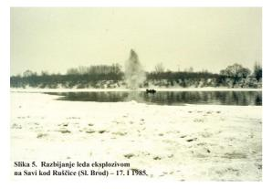
Stvaranje ledenog čepa izaziva nagli uspor vode i porast vodostaja uzvodno kao i opadanje vodostaja nizvodno od čepa. Usporene vode rastu vrlo brzo i prelijevaju se preko odbrambenih sistema te nastaju ledene poplave. Odbrambeni sistemi su projektirani i građeni na mjerodavne velike vode od oborina i u većini slučajeva ne mogu pružiti zaštitu od ledenih poplava.
